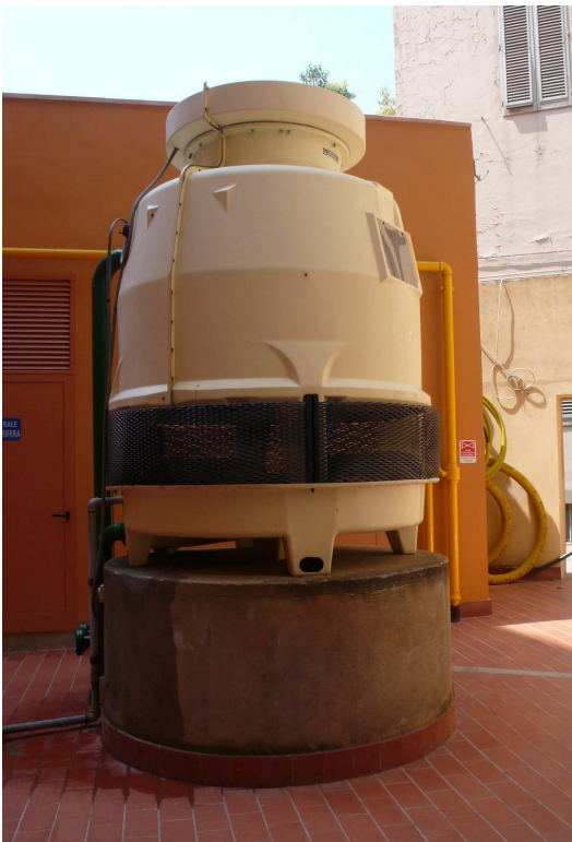
Vista della Centrale Termica 02
