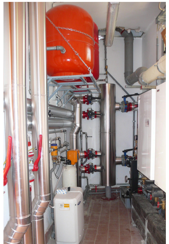
Vista della Centrale Termica 03
