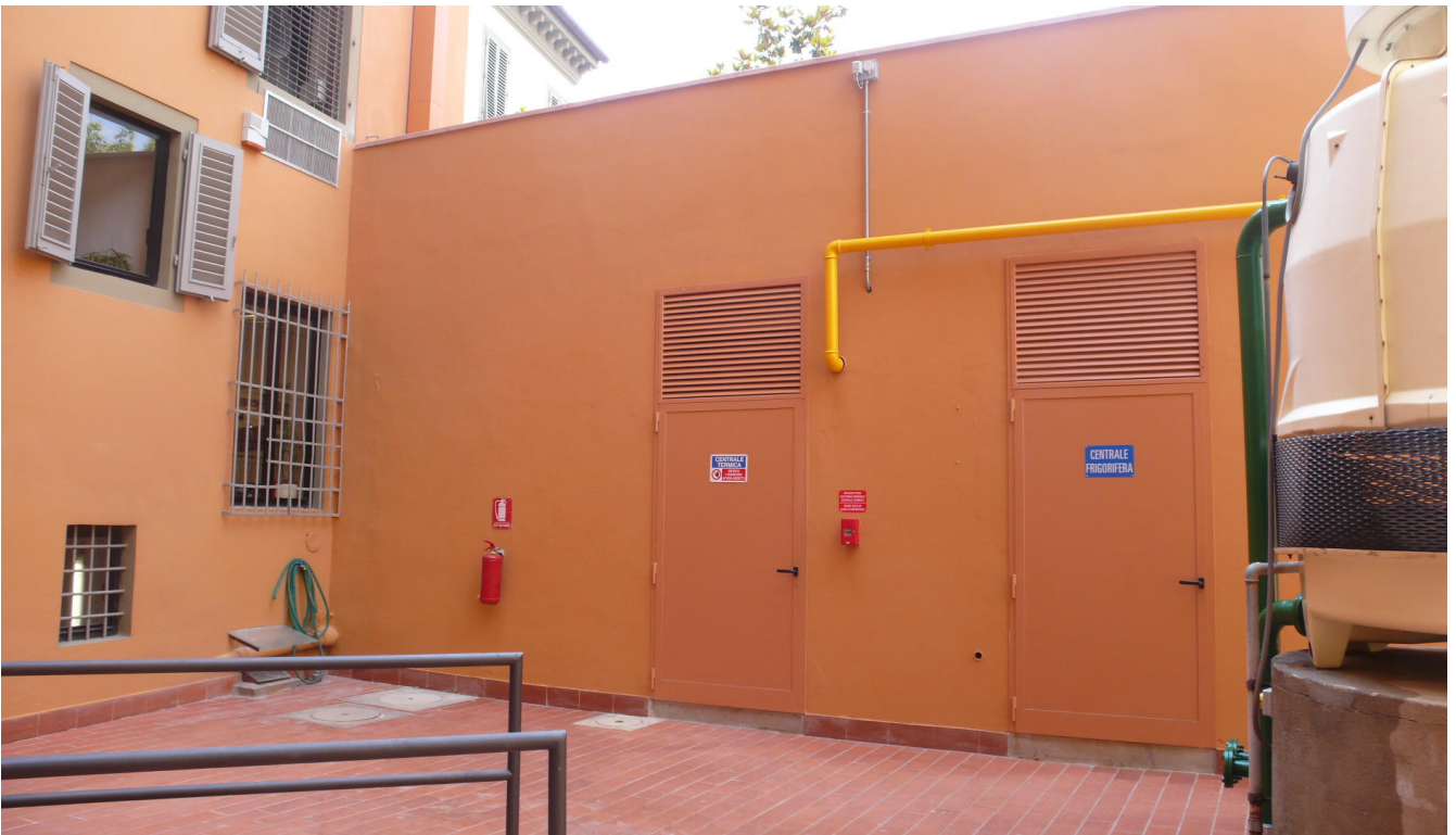
Vista della Centrale Termica 01
