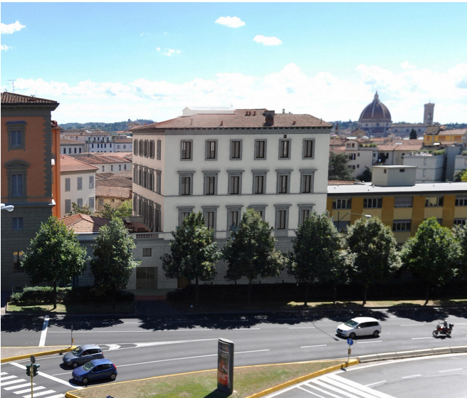
Prospetto su Viale S. Lavagnini
